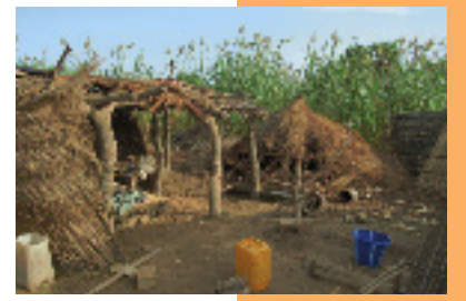
Durch die Überschwemmungen zerstörte Hütten in der Region Makalondi.
