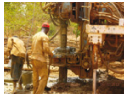
Brunnenbau im Niger
