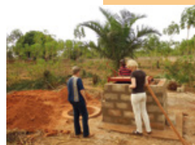
Die neue Müllverbrennungsanlage des Centre Medical Gohomey
