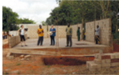
Die Betonplatte für die Biomasse-Anlage
