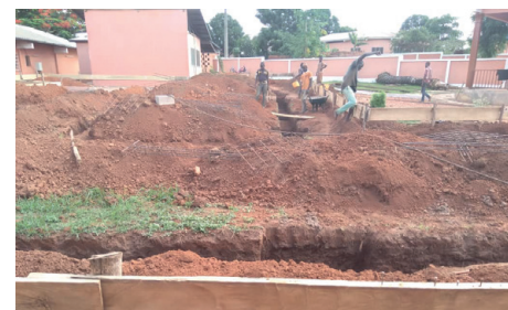
Beginn der Bauarbeiten
