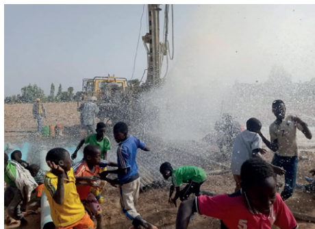
Brunnenbau im Niger Februar 2020
