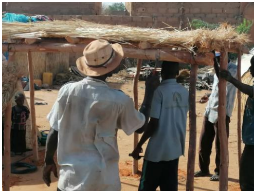
Eine Hütte entsteht
