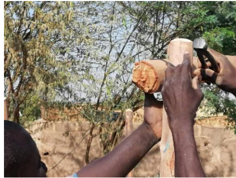
Alle packen an ... beim Hüttenbau
