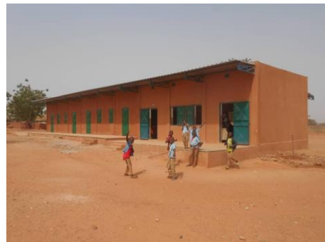
Die Schule – Bau 2020
