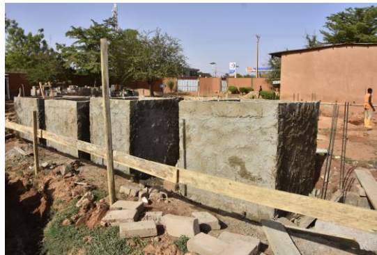
Bau der Maternitée
