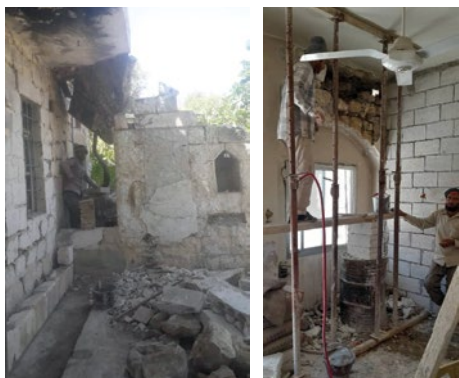
Reparaturen an zerstörten Häusern in Idlib
