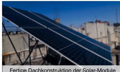
Fertige Dachkonstruktion der Solar-Module
